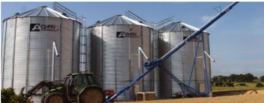
Les équipements de stockage, comme les silos ou cuves, sont évalués en fonction de leur capacité (litres ou m<sup>3</sup>), de leur état général (présence d'oxydation ou corrosion) et de leur conformité avec les normes de conservation.
